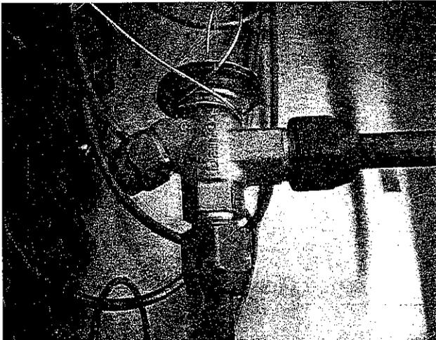
El asiento de la válvula está fijo en el cuerpo de la válvula y el diafragma mueve la aguja. Uno de los lados del diafragma obtiene su presión del bulbo, mientras que el otro la obtiene del evaporador. El diafragma se mueve hacia arriba y hacia abajo en respuesta a tres fuerzas (presiones) diferentes. Estas tres fuerzas son:
